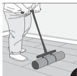
Utilisez un rouleau de sol pour vous assurer que tous les panneaux adhèrent fermement au plancher, puis installez les moulures. Repérez les éventuels espaces entre les panneaux; s'il y en a, utilisez un couteau à mastic pour les remplir avec du mastic et essuyez l'excédent.
